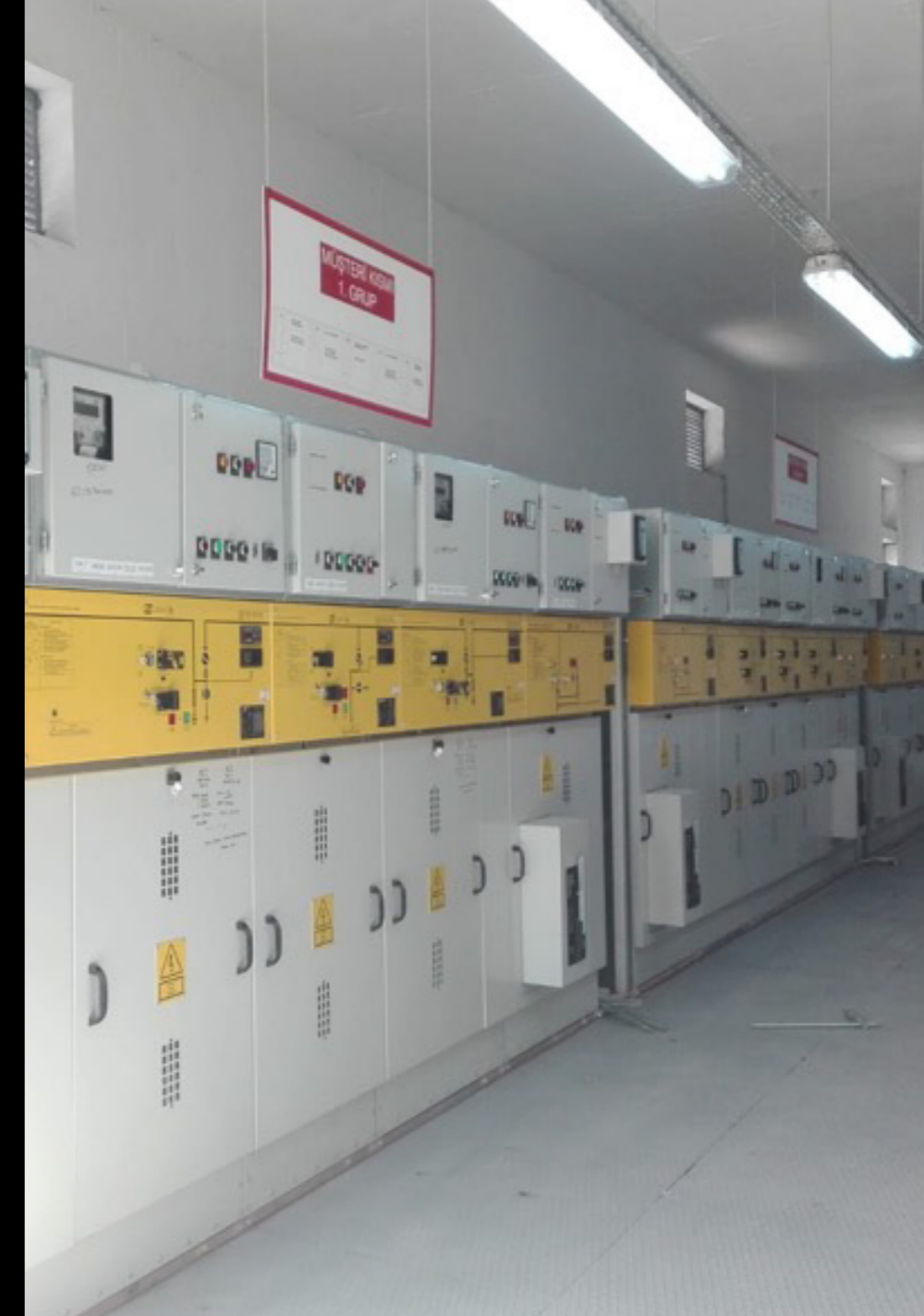
Genel enerji dağıtım merkezi eski tip hücreler yeni tip kapalı hücrelerle değiştirilmiştir.
